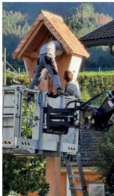
Das neue Kreuz wird montiert
