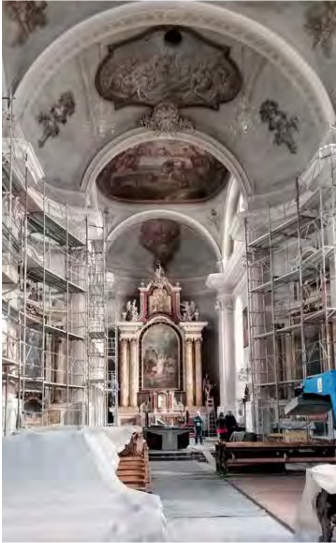
Restaurierung der Pfarrkirche von Niederdorf
