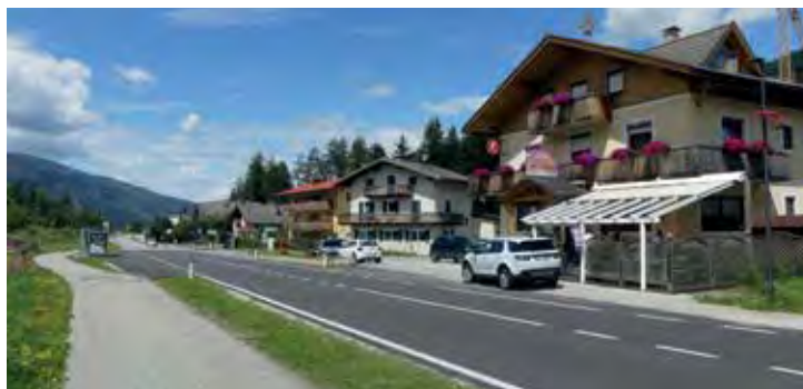
Die sanierte Hauptstraße bei der Einfahrt Weiherbad
