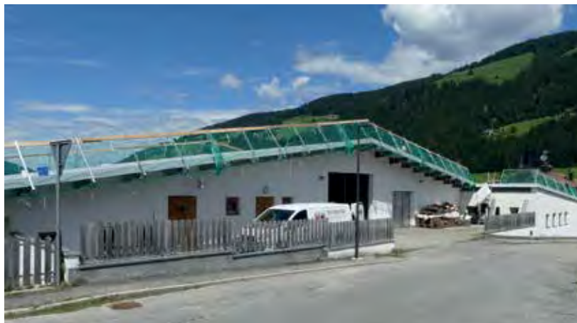
Verstärkung und Isolierung der Dacheindeckung des Bauhofes
