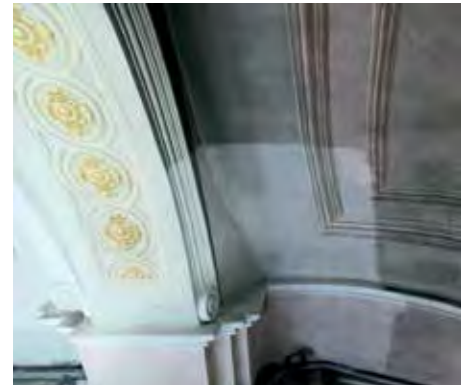
Reinigung der Pfarrkirche in Niederdorf (vorher-nachher)
