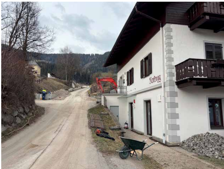
Sicherung des Kassbacher Grabens
