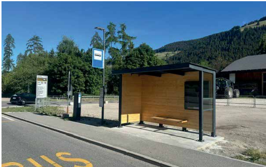
Wartehäuschen bei der Bushaltestelle im Westen
