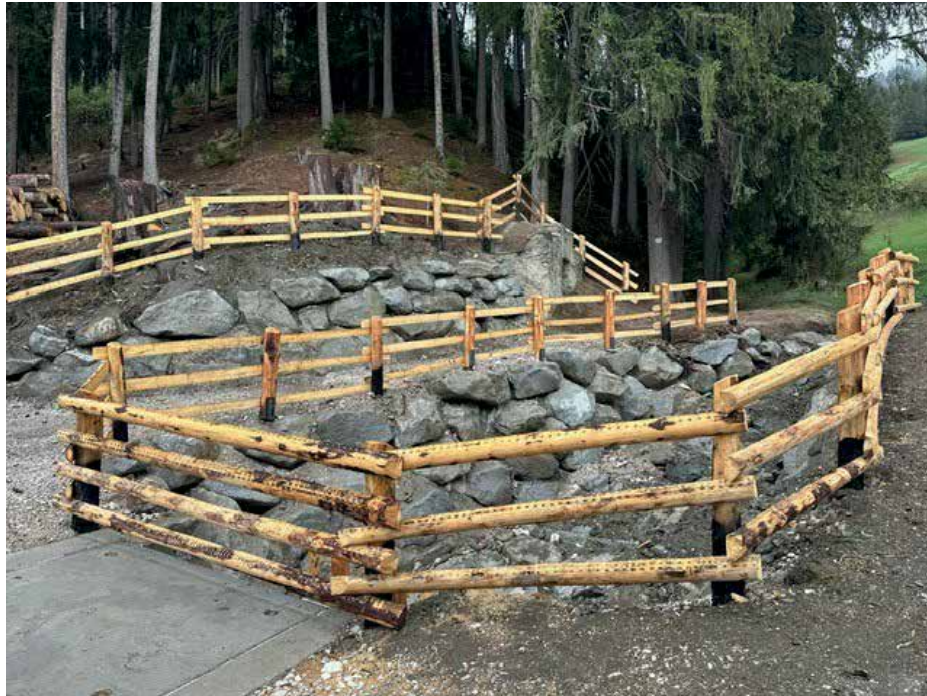
Verbauung beim „Kassbacher-Graben“
