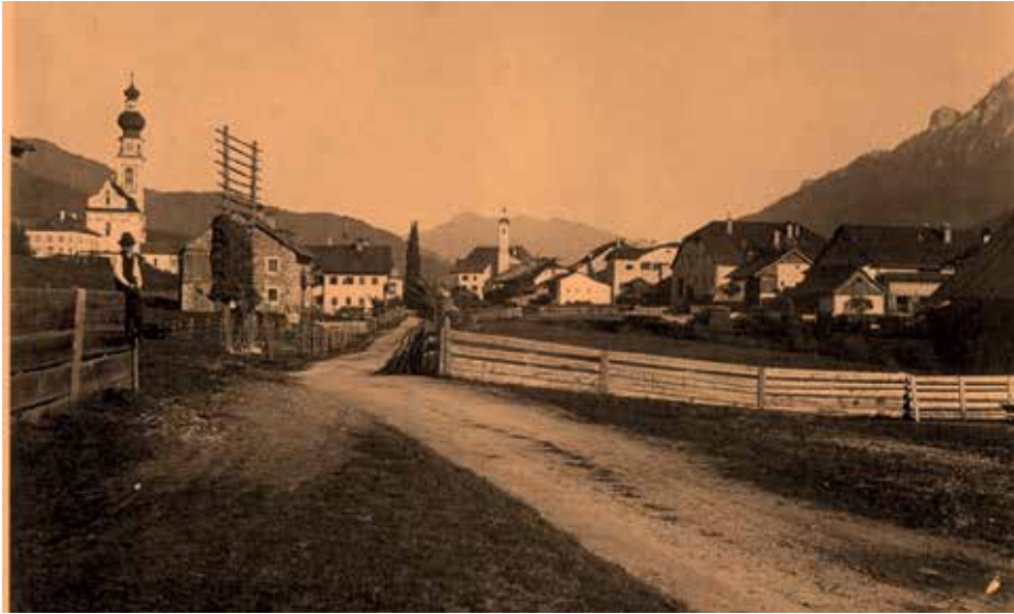
Das Weiße Haus des Alois Außerdorfer in der „Unteren Hauptmannschaft zu Niederdorf“ – die Aufnahme stammt aus dem Jahre 1880. Der Kiesweg vorne rechts führte über die „Garberbrücke“
