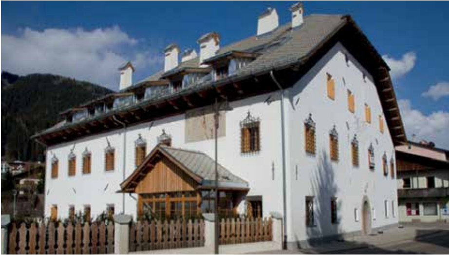
Das Weiße Haus nach der Restaurierung im Jahre 2015 (Süd-West-Ansicht)
