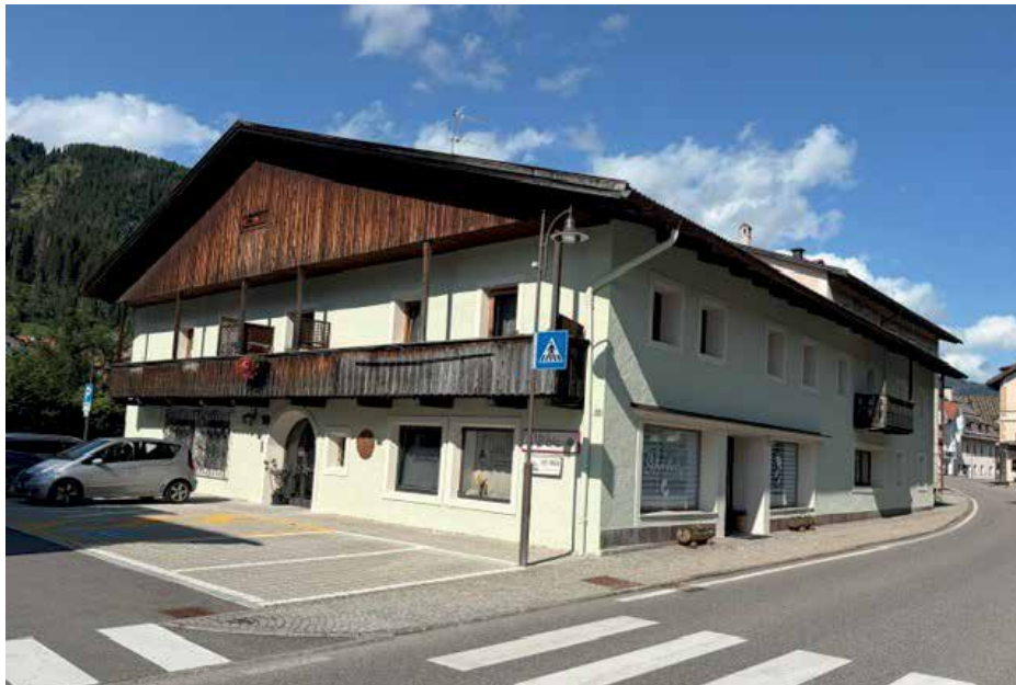
Friedlerhof in Niederdorf mit sanierter Fassade
